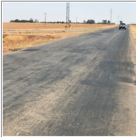
Foto 3 – Afundamentos localizados
