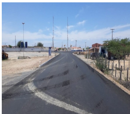
Foto 1 - Ocupação da faixa de domínio
