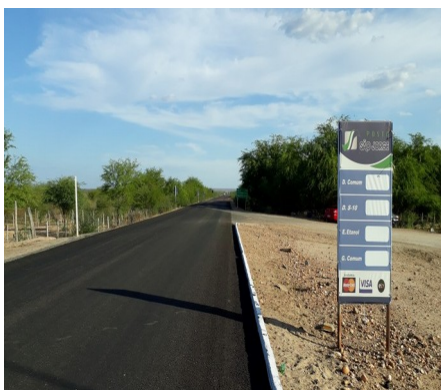
Foto 4 - Ausência de sinalização
