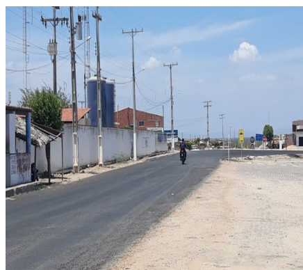
Foto 2 - Ocupação da faixa de domínio
