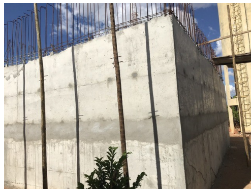
Foto 2 – Construção de Floculador / Decantador
