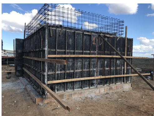
Foto 1 – Execução da Estação Elevatória
