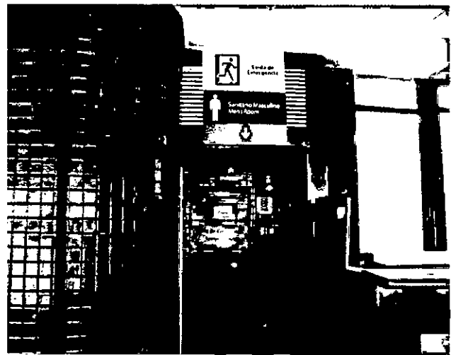
Foto 19 – Porta saída de emergência do 4º piso (2).
