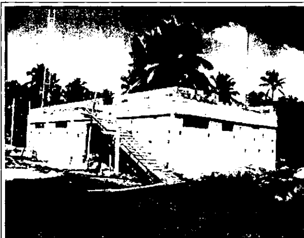
Foto 15: Aspecto da obra de Porto Seguro: obra interrompida após conclusão da superestrutura e início do revestimento (chapisco).
