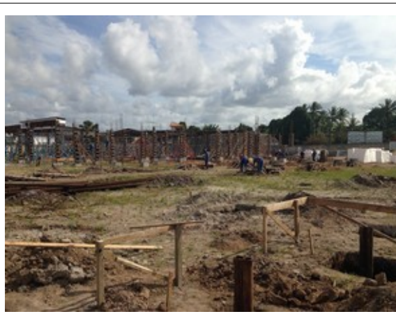
Foto 02 – Vista geral das estacas cravadas com e sem blocos de concreto
