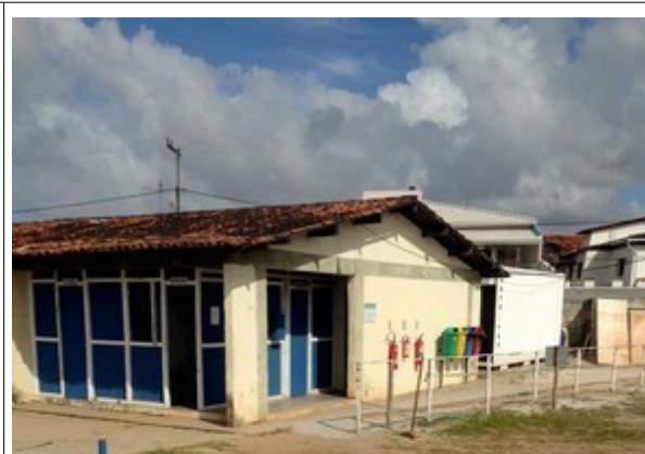
Foto 02 – Construções provisórias da Unidade de Valença substituídas por edificação de alvenaria existente no local.
