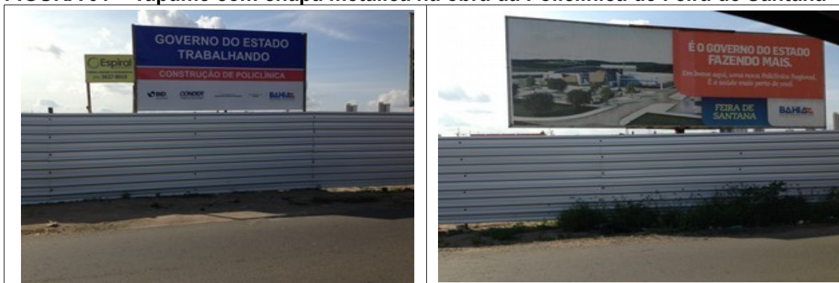
Fotos 01 e 02 - Tapumes executados em chapa metálica, avistando-se, ao fundo, as placas da obra
