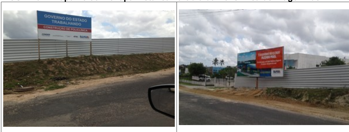
Fotos 01 e 02 - Tapumes executados em chapa metálica, avistando-se, ao fundo, as placas da obra
