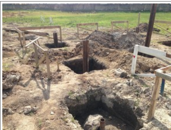
Foto 01 – Estacas metálicas cravadas aguardando execução do bloco de concreto
