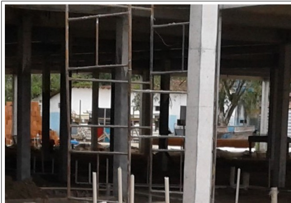
Foto 01 – Vista ao fundo do escritório da obra da Policlínica de Santo Antônio de Jesus em edificação de alvenaria em substituição aos barracões de chapa de madeira compensada
