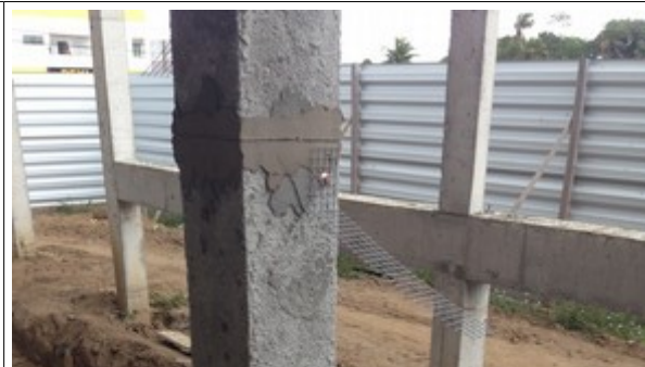
Foto 02 – Tapume executado em chapa metálica
