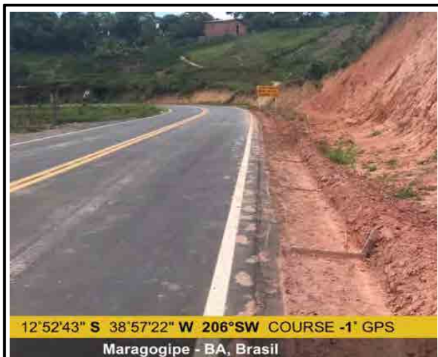
Corte E-830/850 LD Sarjeta em execução
