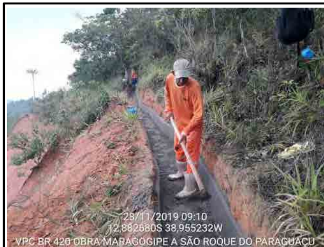
Corte E-870 LD Valeta de proteção de corte executada
