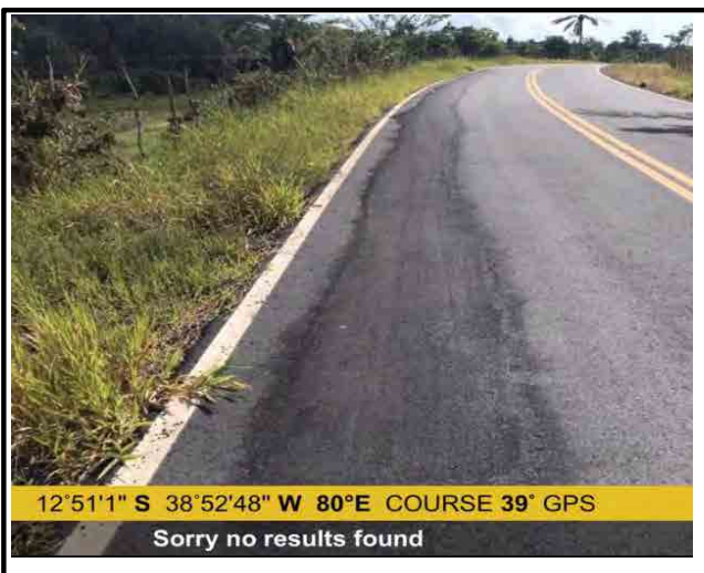
BA 420 remendo executado no pavimento
