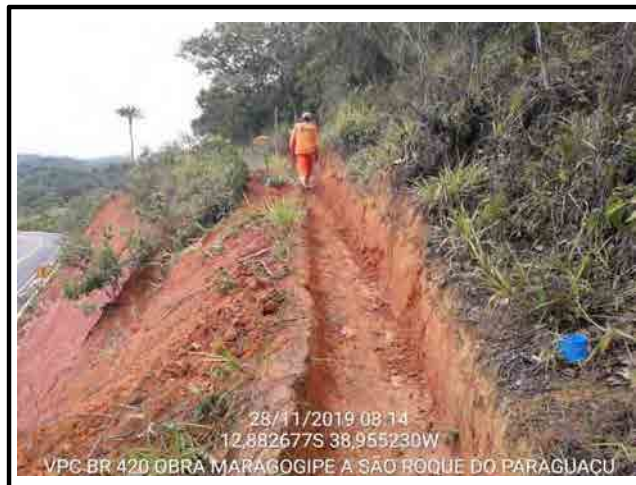
Corte E-870 LD Valeta de proteção de corte em execução
