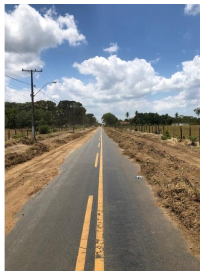
Foto 2: Estaca 310 durante execução da roçagem
