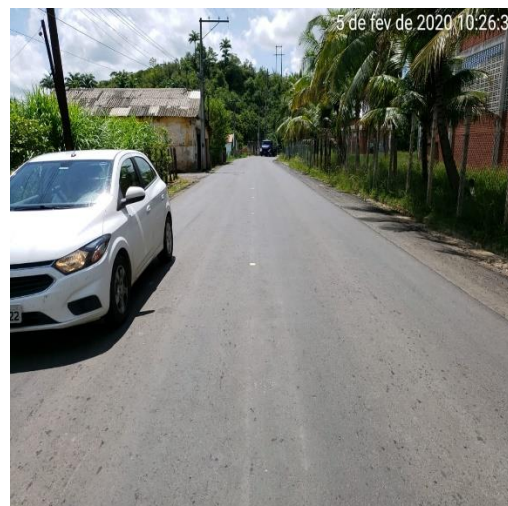
Foto 8: Marcação de eixo para delimitar a faixa
