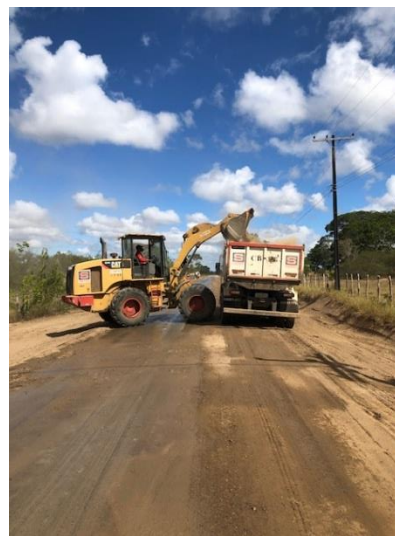
Foto 4: Estaca 210 durante execução da roçagem
