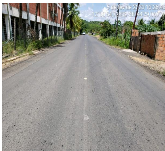
Foto 7: Marcação de eixo para delimitar a faixa
