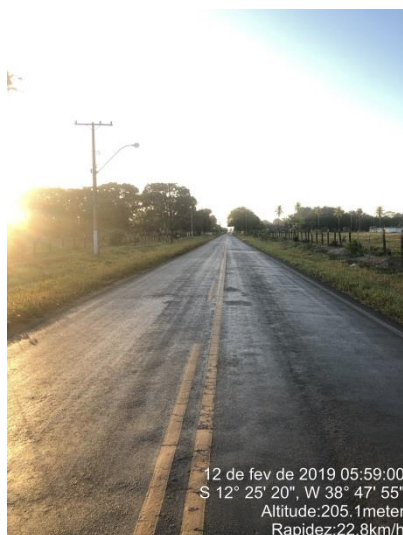
Foto 1: Estaca 310 antes do início da obra
