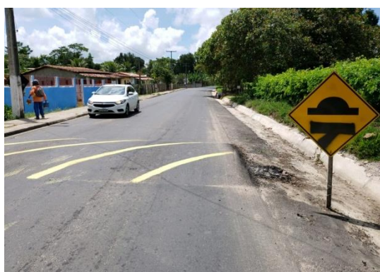
Foto 5: Sinalização provisória nos quebra-molas
