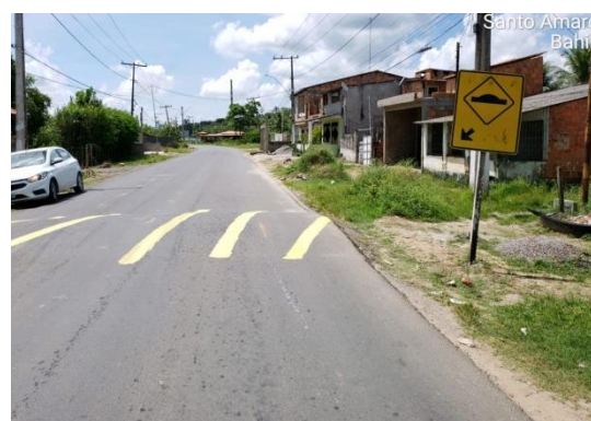
Foto 6: Sinalização provisória nos quebra-molas
