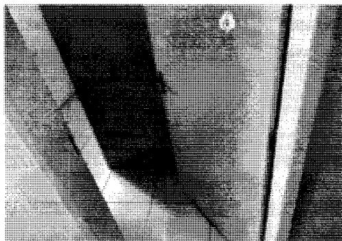
**Foto 11 – Rejunte, piso cerâmico e pintura esmalte**
